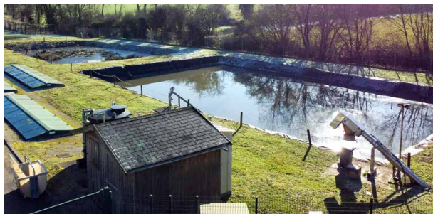
Station d'épuration de Tresbœuf
